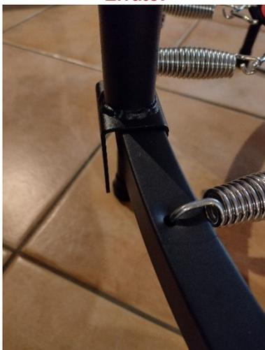
Se la barra è montata nel modo illustrato in questa figura, non terrà. Il tipo di montaggio rende il palo instabile, aumentando il rischio di incidenti e lesioni.
